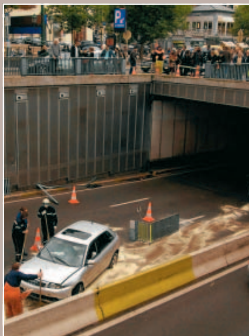
3 TUNNEL TOISON D'OR LA VOITURE ÉTAIT TOMBÉE
