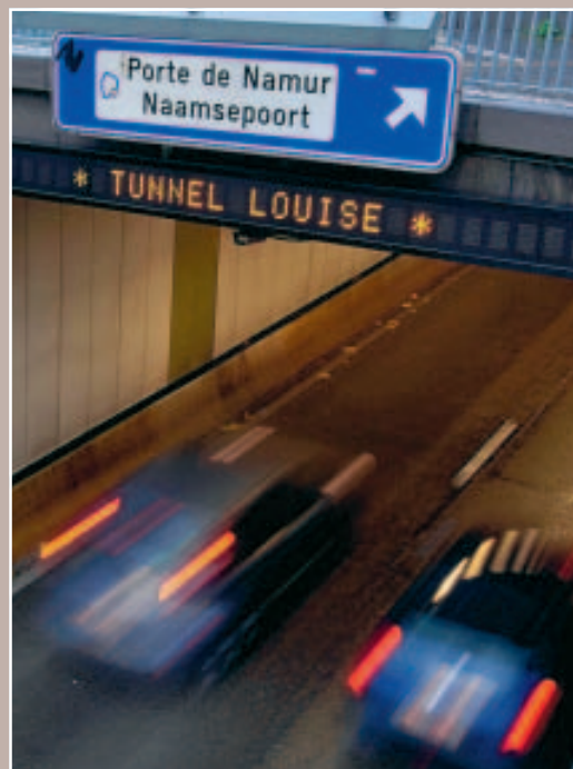
4 LE TUNNEL LOUISE LA PAROI CENTRALE MANQUE AUSSI
