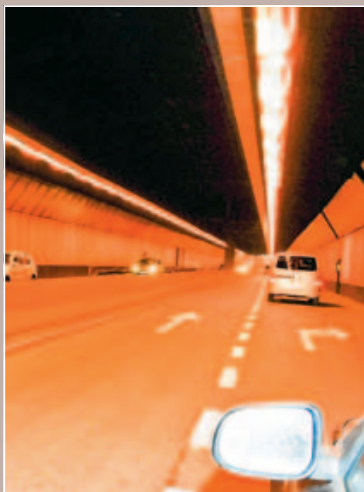
2 LE TUNNEL STÉPHANIE LA PAROI CENTRALE MANQUE
